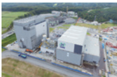
三木バイオマスファクトリー 現在(建設中)
