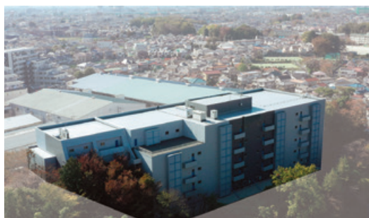
関東主管センター
