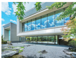
郡山モノリス(福島県郡山市)
