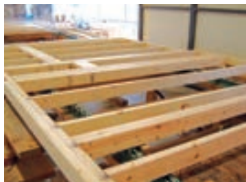
プレカット加工した材木からパネルの枠材を作成
