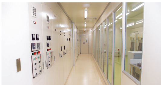
横浜細胞処理センター内部
