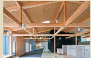
大規模木造建築（非住宅）の事例
