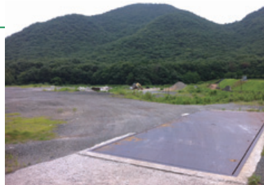
〈安定型最終処分場〉
