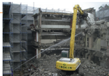
〈ビル解体工事〉
