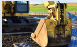
マシンコントロール
