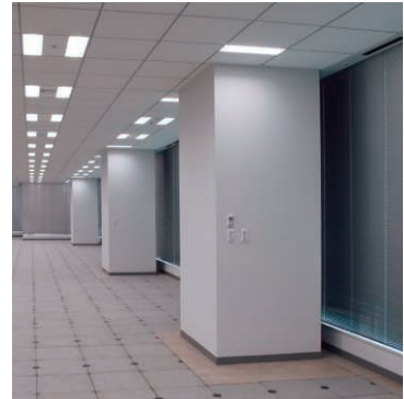
柱の耐火被覆（事務所）
