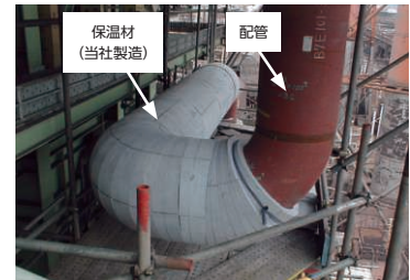
保温材取付け (施工中)
