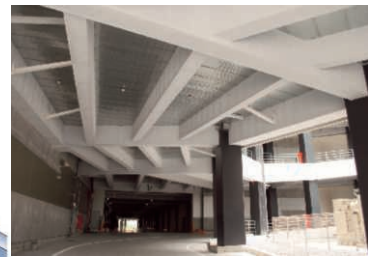
はりの耐火被覆（物流施設）
