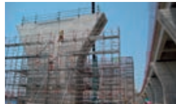
当社足場製品が使用された大規模工事現場
