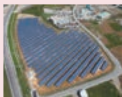
田老太陽光発電所 (岩手県宮古市) (注)2
