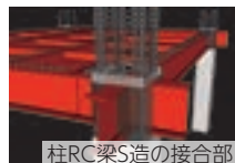
柱RC梁S造の接合部
