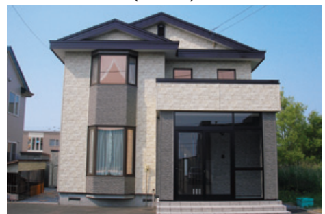
(金属サイディングによる四面張り一例)
