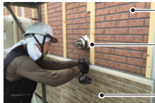
(施工現場風景)
