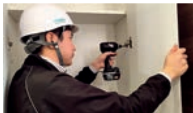
メンテナンス施工
