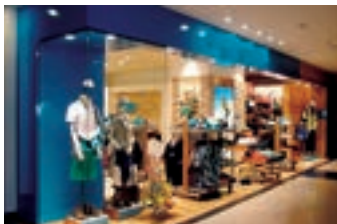
店舗内装工事
